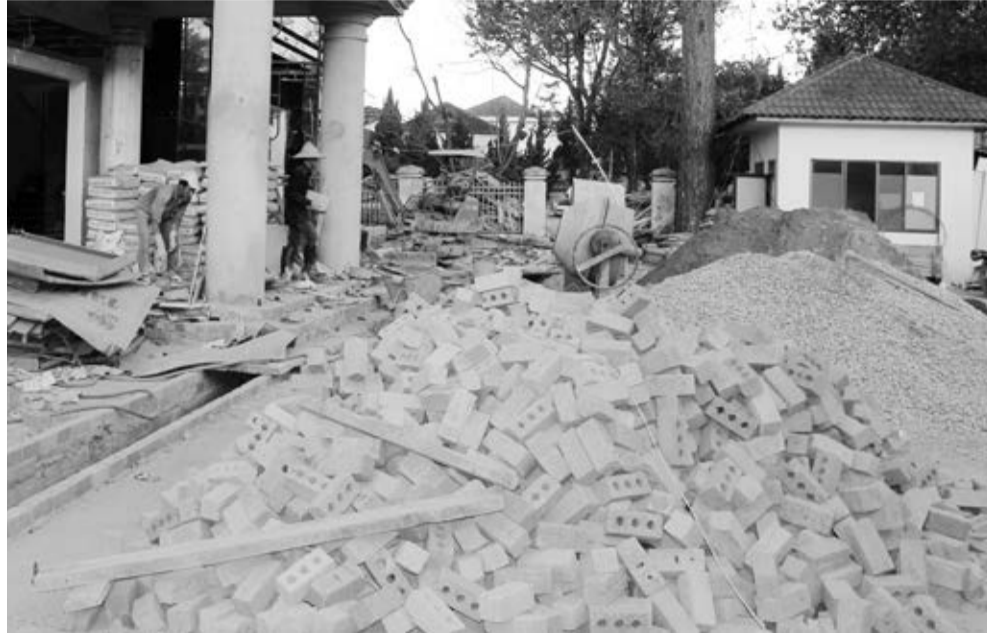
Sản phẩm gạch không nung mới chất lượng tốt hơn đang tập kết tại công trình. Ảnh: M.Đào
