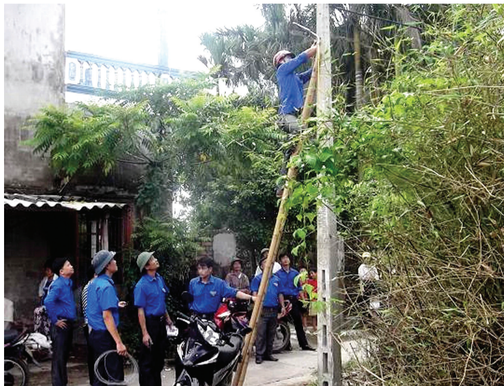
ĐVTN xã Đa Tồn tham gia thực hiện công trình “Thắp sáng đường quê”. Ảnh: K.Phúc
