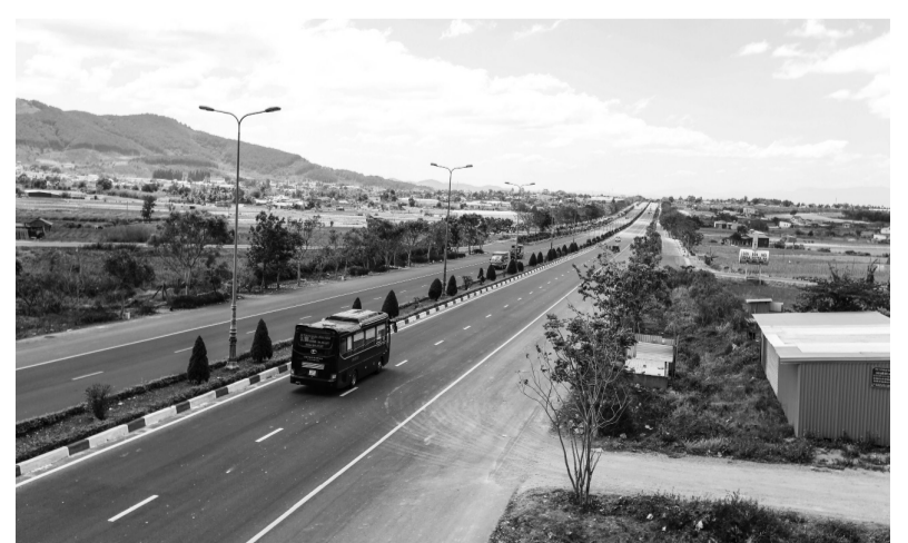
Dự án cao tốc Dầu Giây - Liên Khương sẽ có nguồn vốn đầu tư công trung hạn 2021-2026. Trong ảnh: Đoạn đầu cao tốc Liên Khương - Prenn.
