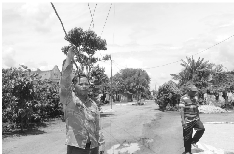
Đường dây điện Xóm 4 với tay là có thể kéo xuống được.
