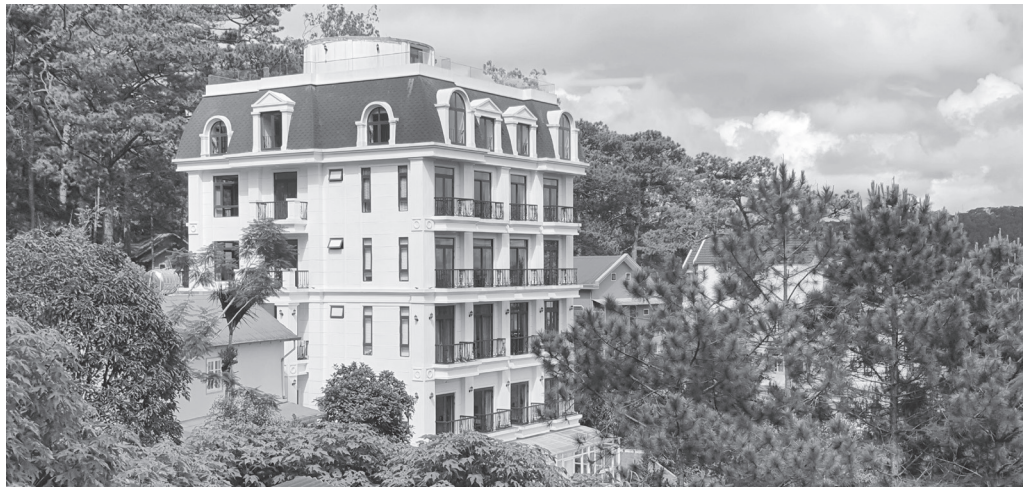
Công trình biệt thự xây dựng sai phép tại số 6B Trần Quang Diệu TP Đà Lạt.
