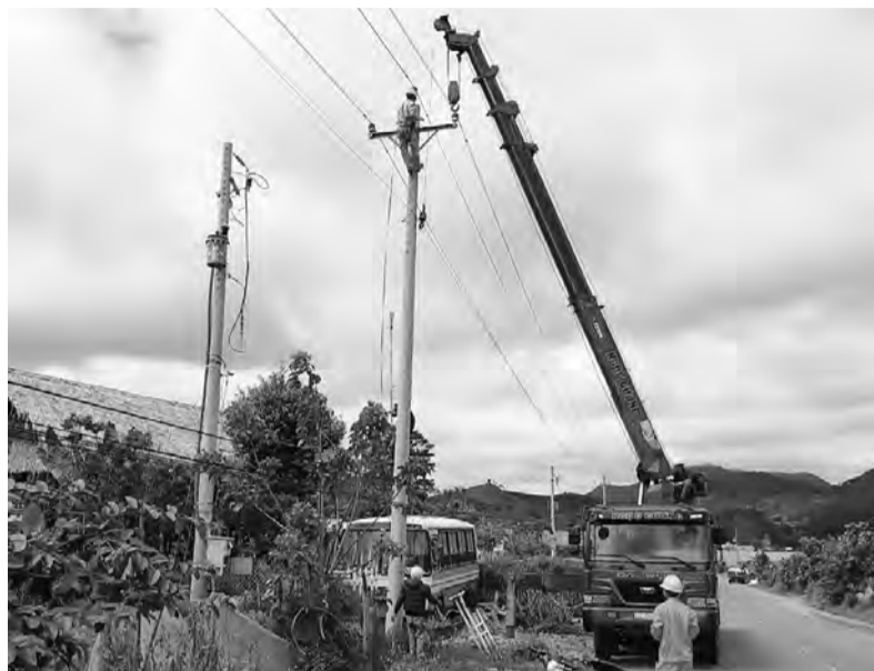
Điện lực Lạc Dương thực hiện các công trình đưa điện về vùng sâu, vùng xa.
