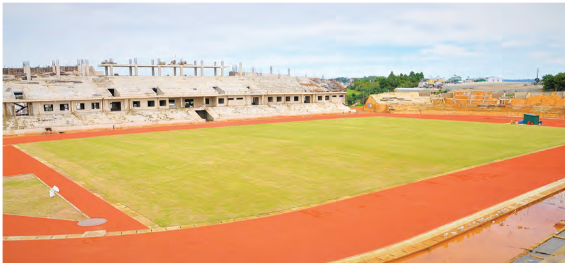
Mặt cỏ và đường chạy quanh sân đã được hoàn tất.
