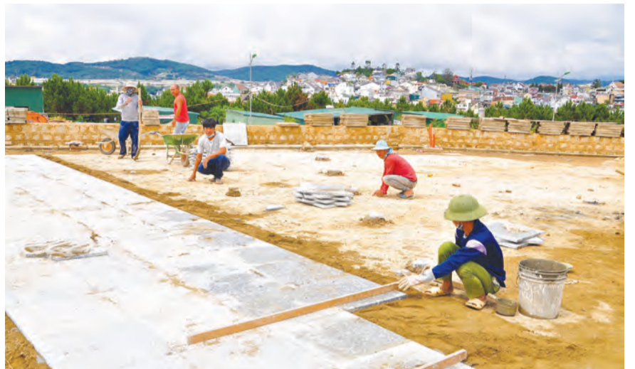
Các hạng mục đang được đẩy nhanh tiến độ thi công.
