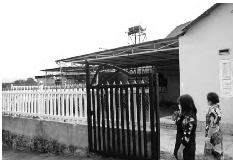
Cho rằng con đường phía trước nhà là phần đất của gia đình, ông Trần Đình Hòa đã tự ý xây hàng rào kiên cố dài 16 m, bao kín lối đi vào phần đất của bà Võ Thị Minh Trí.
