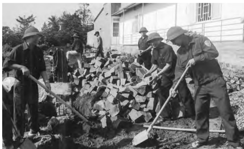
CCB tham gia xây nhà nghĩa tình đồng đội.
