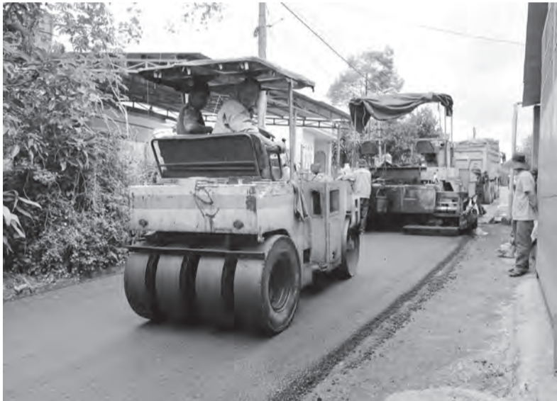
Người dân Tổ dân phố 4 (phường Lộc Tiến) làm đường giao thông.
