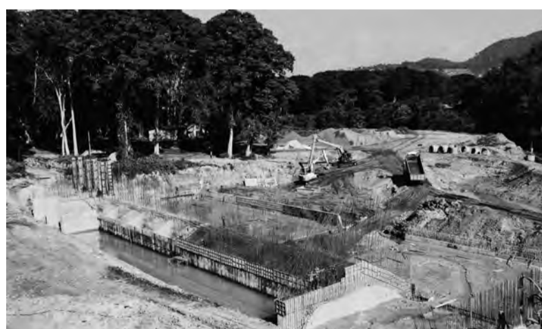
Đơn vị nhà thầu đang thi công phần thân đập chính của Công trình Đập thủy lợi Bằng Lăng.
