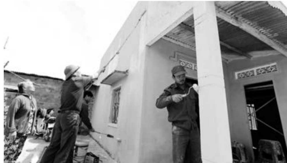
Các cán bộ, chiến sỹ Ban CHQS huyện Đơn Dương tham gia xây nhà tình nghĩa cho gia đình tân binh Lâm Vi Hòa tại xã Ka Đô.
