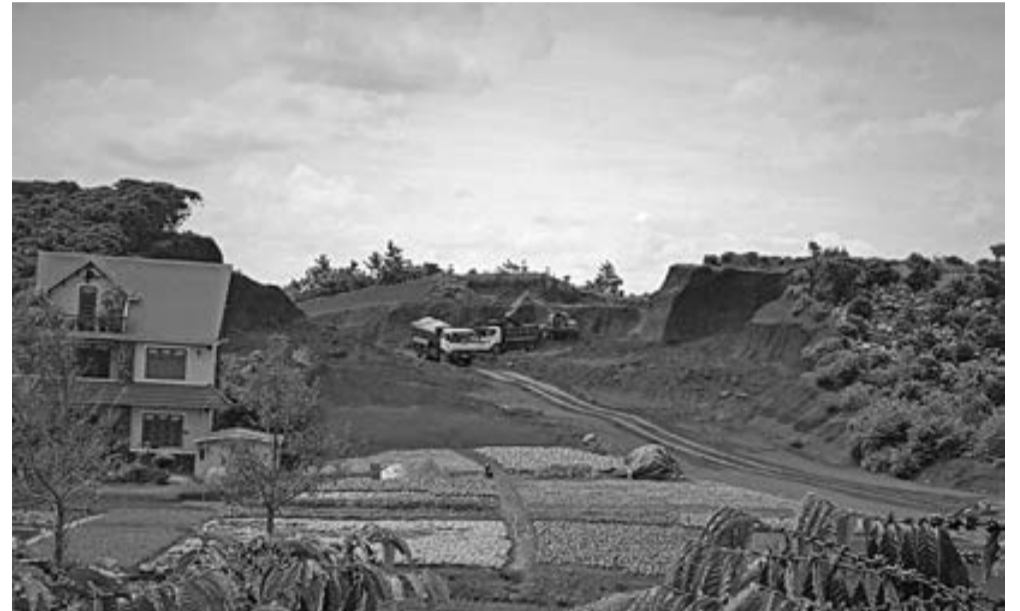
Mặc dù bị nghiêm cấm nhưng nhiều đối tượng khai thác đất trái phép trên địa bàn TP Bảo Lộc vẫn cố tình vi phạm. Ảnh: H.Đ
