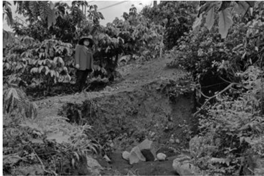
Nước mưa đã tạo thành các rãnh sâu làm hư hỏng đường vào khu sản xuất. Ảnh: L.P
