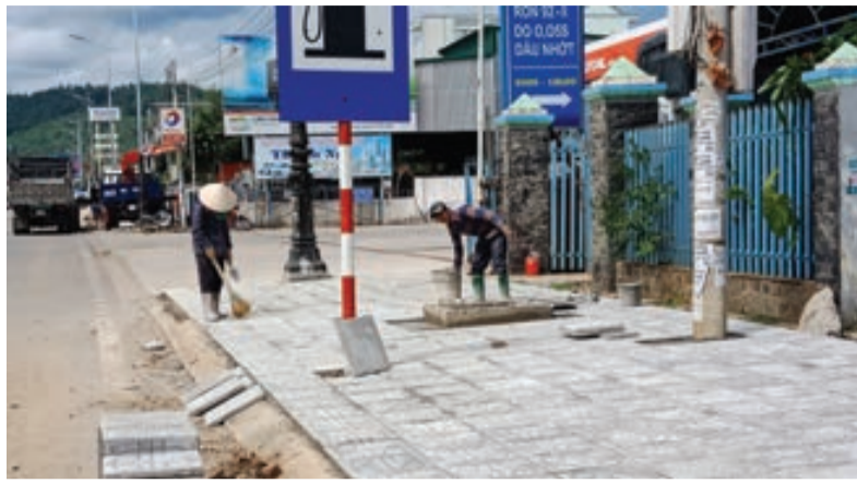
Thi công lát vỉa hè đoạn Quốc lộ 20 chạy qua xã Hiệp Thạnh. Ảnh: Võ Lan
