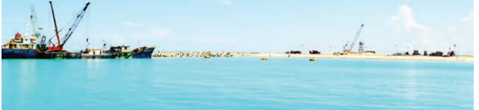
Âu tầu đang được xây dựng trên đảo Trường Sa Lớn. Ảnh: VT
