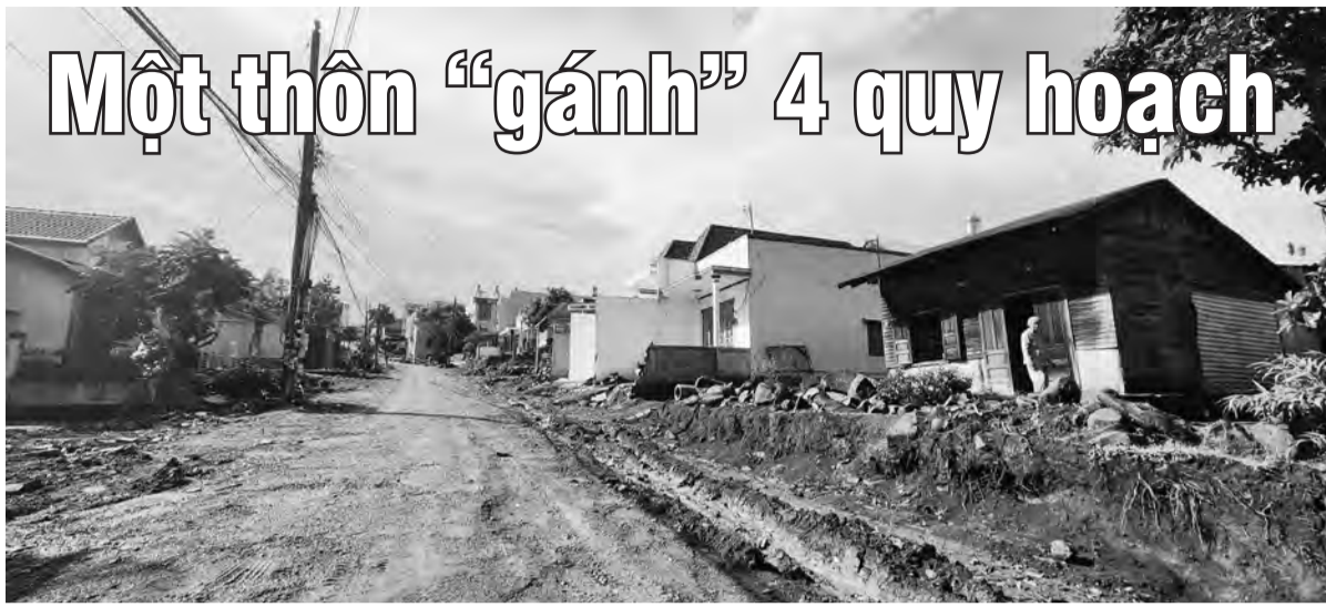
Toàn thôn Tân Bình (xã Lộc Châu, TP Bảo Lộc) hiện có khoảng 15 hộ dân có nhà cửa bị xuống cấp, nhưng không thể xây mới, sửa chữa do đang phải cùng lúc “gánh” 4 quy hoạch.
