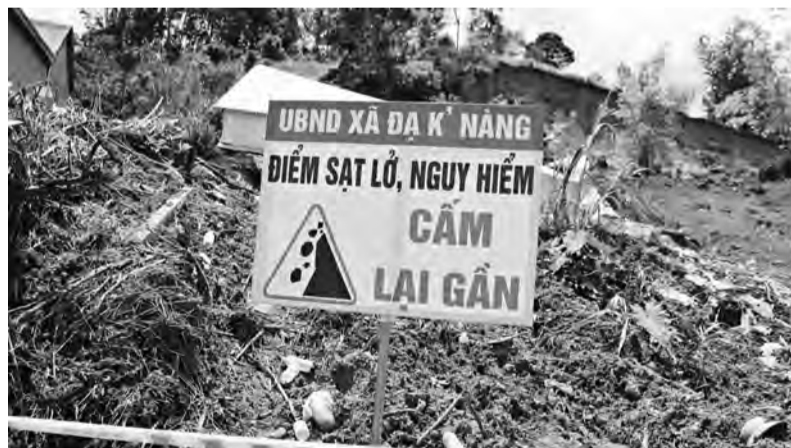
Các khu vực đồi dốc phía dưới có dân cư sinh sống, các địa phương cùng người dân đang khẩn trương giạt cấp taluy, hạ tải trọng đỉnh đồi mái dốc.
