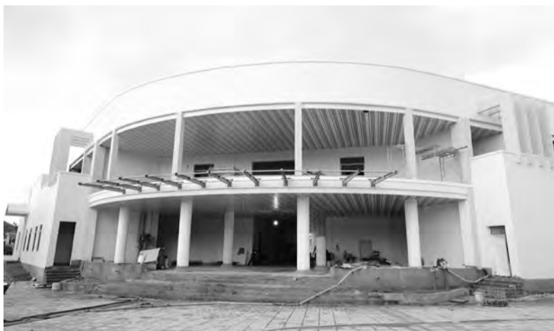
Khối công trình Nhà thiếu nhi huyện Lâm Hà hiện đã thi công xong phần thân, phần mái.
