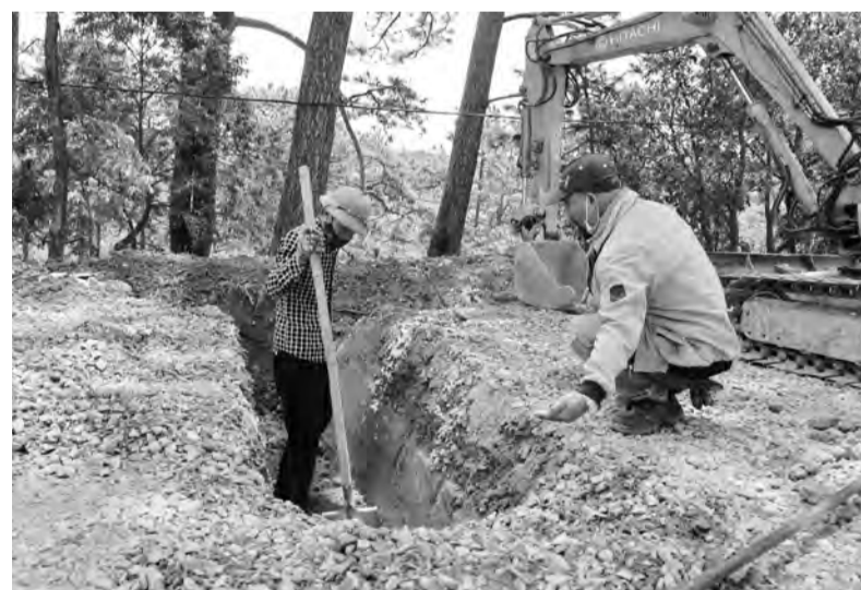
Công nhân triển khai ngầm hóa điện chiếu sáng.
