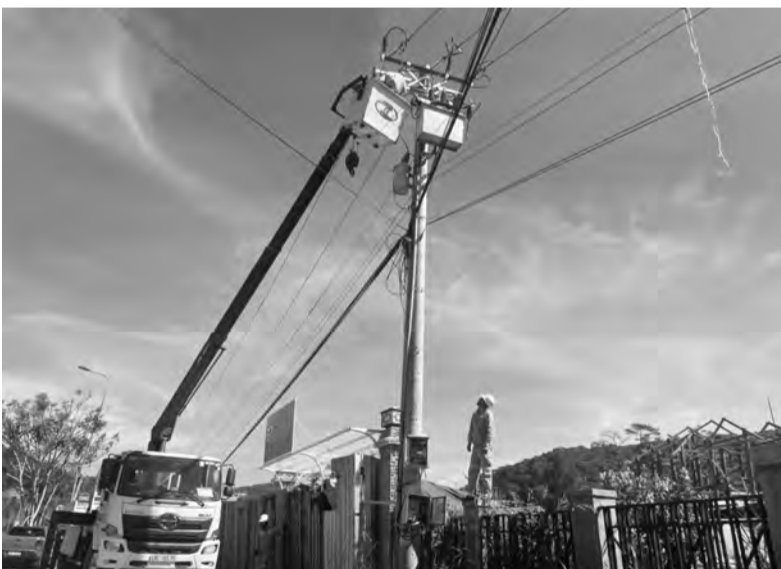
Điện lực Đức Trọng chú trọng công tác cải tạo, sửa chữa, bảo dưỡng hệ thống lưới điện, khắc phục sự cố, đảm bảo vận hành an toàn.
