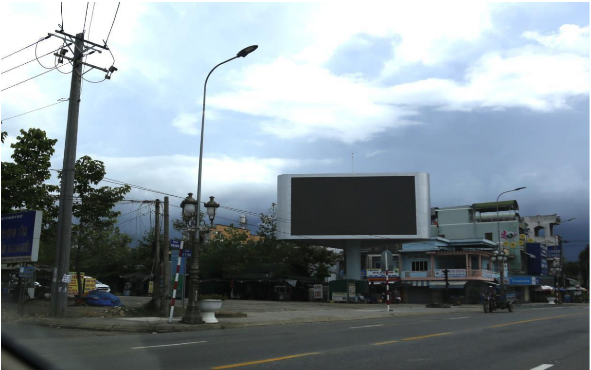
Màn hình LED khu vực giao đường Hùng Vương - đường Lê Lợi, huyện Di Linh
